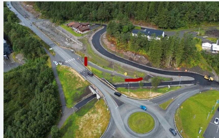
Trafikken går langs en omkjøringsveg mens det jobbes på fylkesvegen. FOTO: EIVIND FINNES
