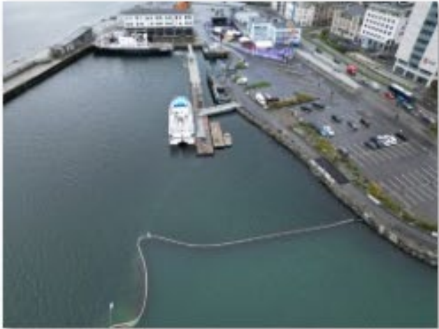
Dronebilder 5 sep Hurtigbåtkai og siltgarding DJI_0055
