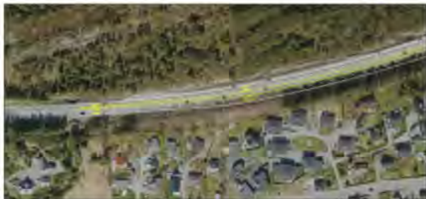
Det blir 400 meter med fire felt på innfartsvegen vest for Lerstadtunnelen. FOTO: BYPAKKE ÅLESUND/STATENS VEGVESEN
