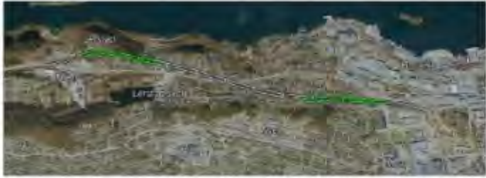
Grønne linjer viser framdrifta for E136 Lerstadtunnelen rett før påske. ILLUSTRASJON: STATENS VEGVESEN
