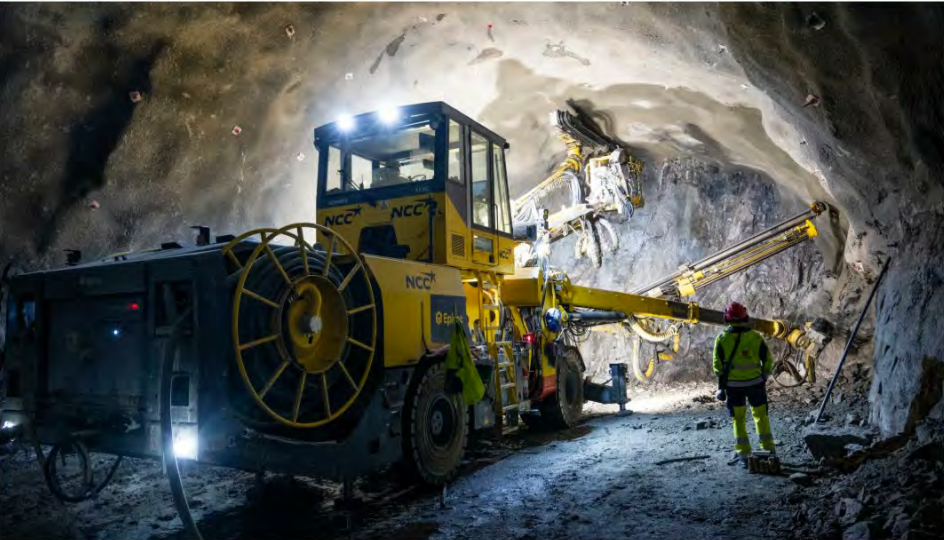
NCC holder fremdriften under drivingen av Lerstadtunnelen i Ålesund. Nå er halvparten av tunnelen ferdig drevet. Foto: Ole Kristian Åset, Statens vegvesen
