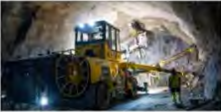
For hver salve kommer de seg rundt fem meter innover i berget. FOTO: OLE KRISTIAN ÅSET / STATENS VEGVESEN
