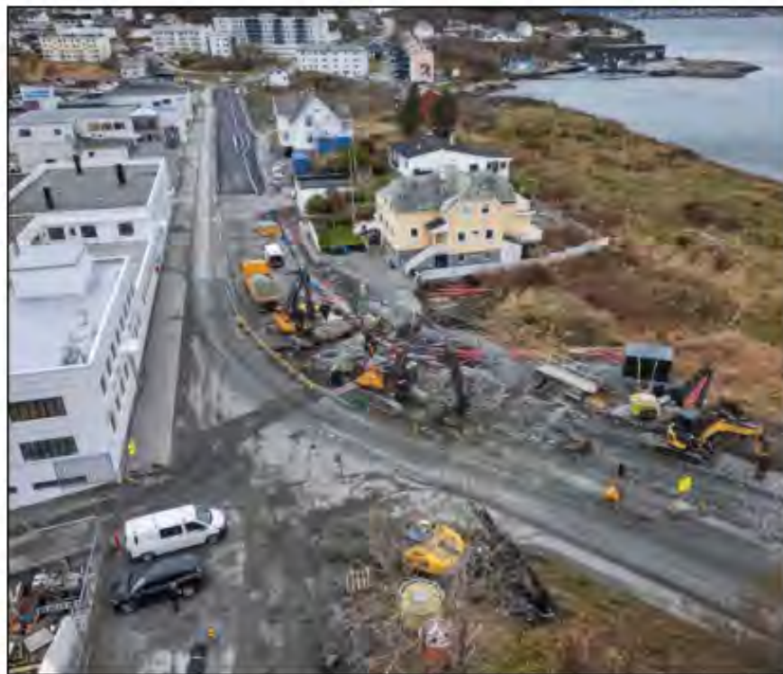
Opprinnelig skulle det bare bygges nytt sykkelfelt og fortau mellom Brogata og Tuenes-krysset. FOTO: STAAL WATTO
