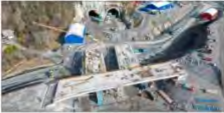
Ved tunnelmunninga på Lerstad. FOTO: CHRISTIAN IBSEN / STATENS VEGVESEN
