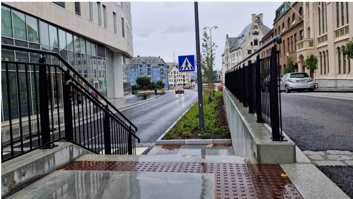
Figur 8: Oppgraderte Korsegata, en del av kollektivknutepunktet i Ålesund sentrum.
